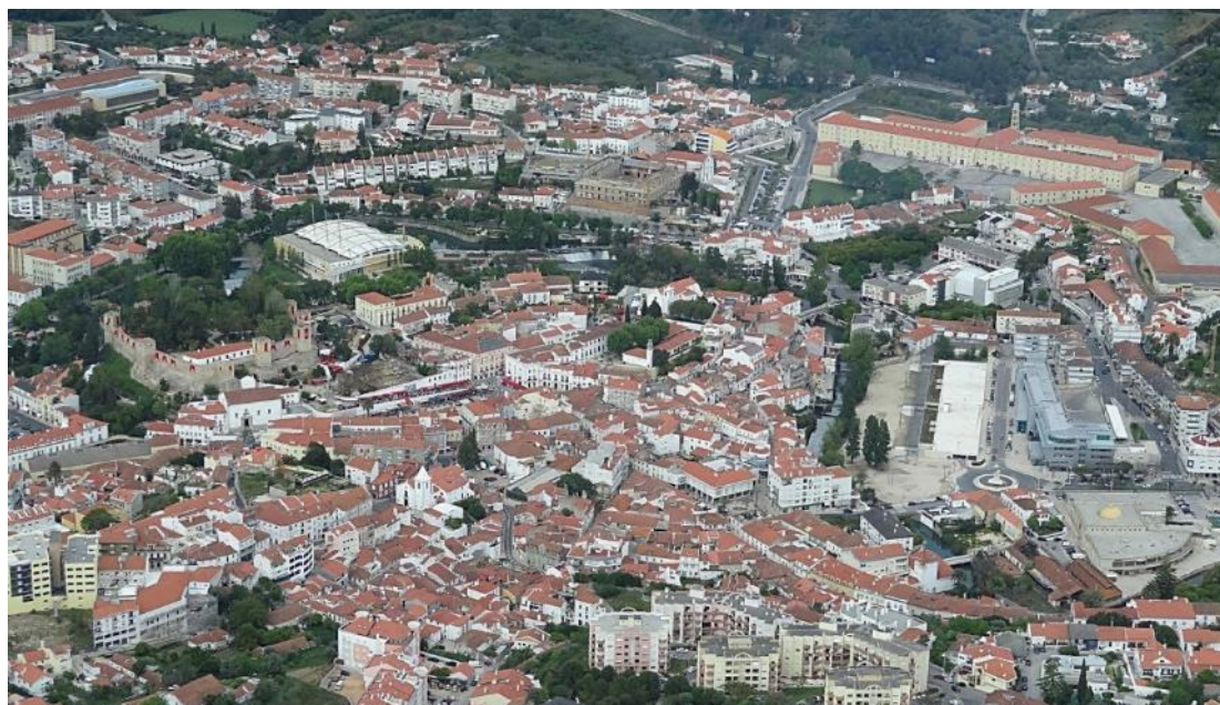
Figura 8. Torres Novas – vista área
