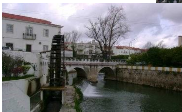
13 — Ponte da Levada —
