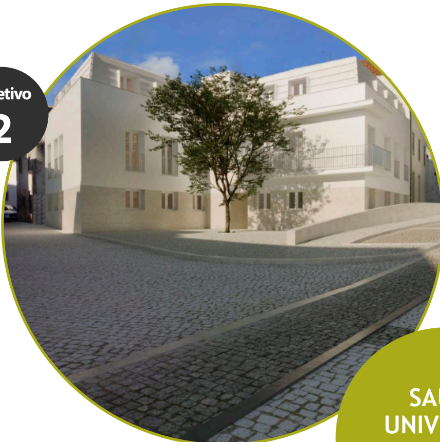
Construção de Edifício de Habitação Multifamiliar no Gaveto da Rua Atriz Virgínia com a Rua dos Ferreiros
