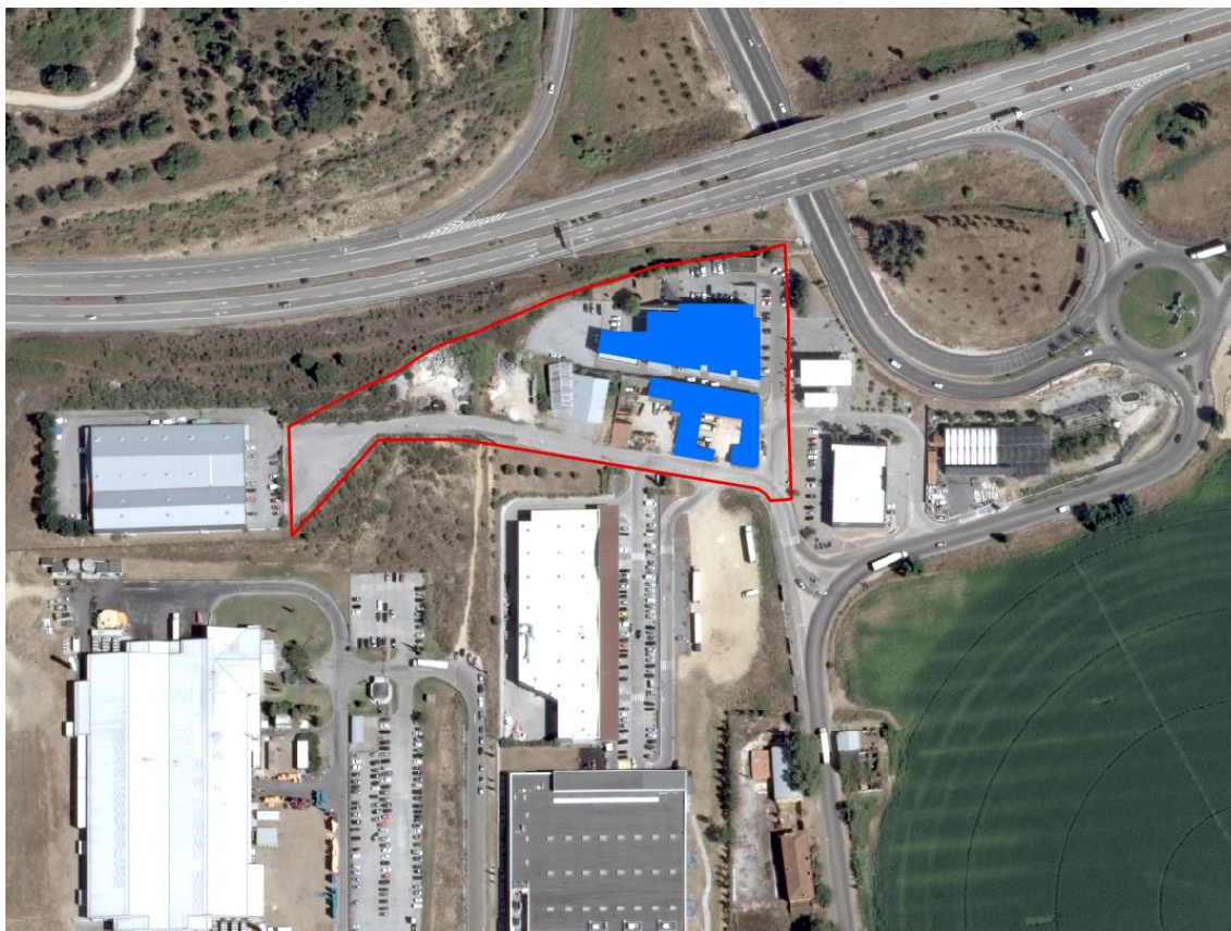
Figura 1 - área de incidência do procedimento de normas provisórias do PDMTN com o limite (a vermelho) da área de intervenção e construções a manter (a azul)
